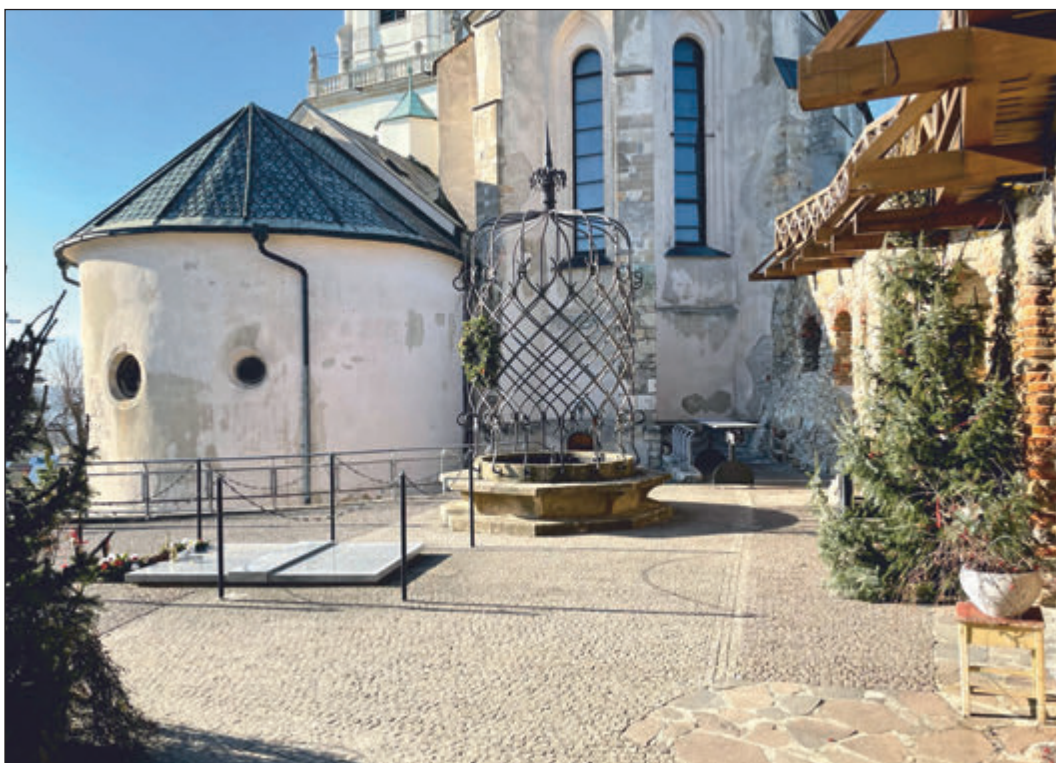
Obr. 5. Nitra, hrad. Pohľad na rozdielnou dlažbou vyznačené architektúry na východnom nádvorí.
