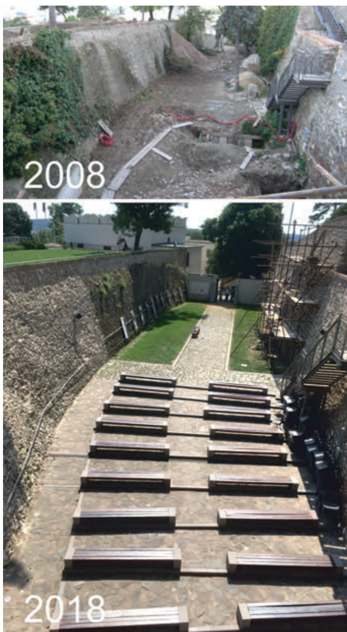
Obr. 8. Nitra, hrad. Priestor vnútornej priekopy počas a po obnove – amfiteáter. (zdroj: archív autora).
