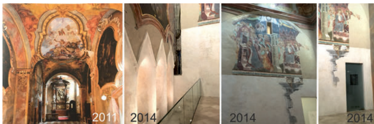
Obr. 10. Nitra, hrad. Interiér južnej lode Katedrály sv. Emeráma pred obnovou a po obnove. Na pôvodnom mieste oltára Snímania z kríža v súčasnosti prezentovaná freska zo 14. stor. Analyticky prezentované sedílie na severnej stene lode (zdroj: archív autora).
