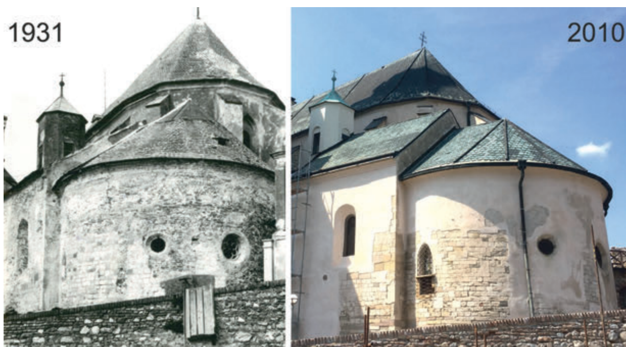
Obr. 1. Nitra, hrad. Kaplnka pred obnovou s režným murivom – románskym kamenným koádrovým a gotickým tehlovým. Po obnove zmena krytiny strechy, zmena štítu a sklonu strechy nad loďou kaplnky zamedzenie prístupu do otvoru malej vežičky, ako aj omietnutie tehlového muriva kaplnky (zdroj: Archív PÚ SR 1931; archív autora 2010).
